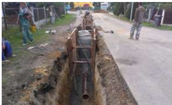
Výstavba nové kanalizace v lokalitě Sklárna
