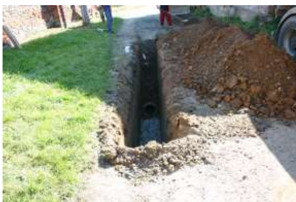
Výstavba nové kanalizace v ul. Na Staré cestě
