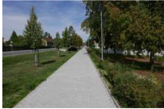
Rekonstrukce chodníku při komunikaci ul. Plzeňská
