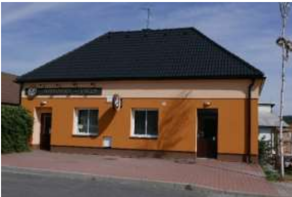
Oprava střechy a fasády – hostinec Formanka
