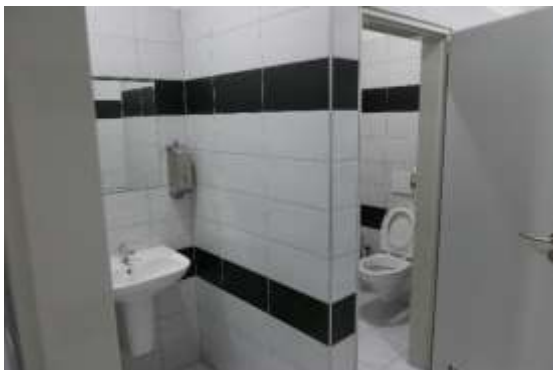
Sociální zařízení v rekonstruované části MěÚ
