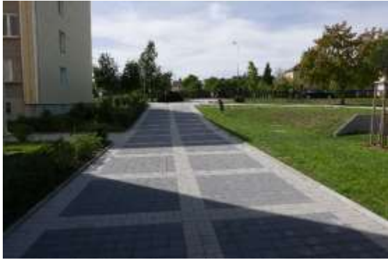
Rekonstrukce chodníku v sídlišti
