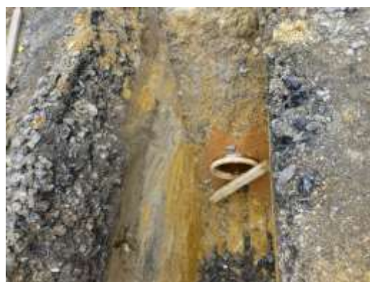
Rekonstrukce kanalizace v ul. Lidická
