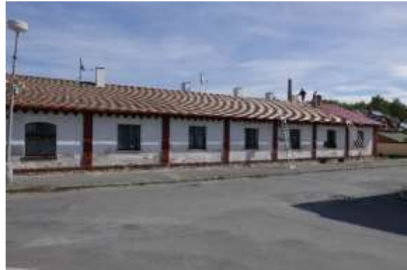
Oprava střechy – bytový dům v ul. Luční
