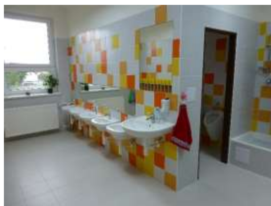
Rekonstrukce sociálního zařízení MŠ sídliště
