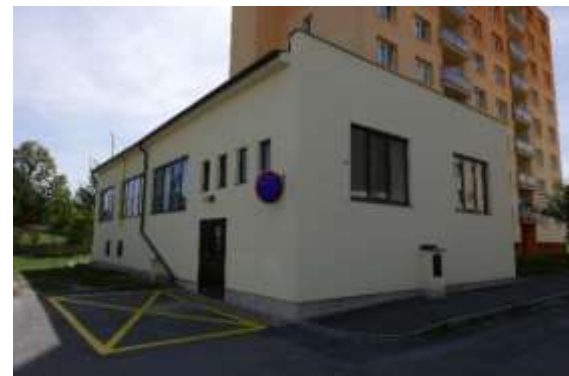
Oprava fasád kotelen v sídlišti
