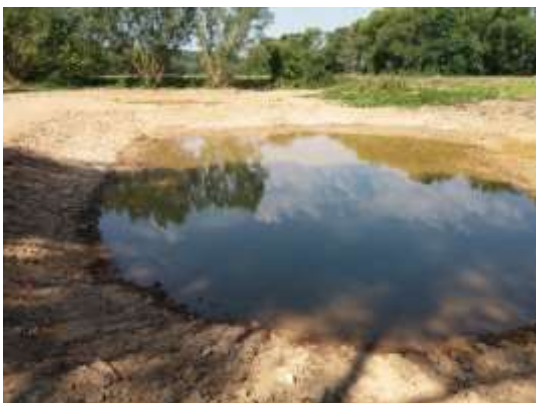
Výstavba tůň v lokalitě bývalého koupaliště v Záluží
