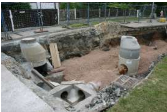
Výstavba nové kanalizace v lokalitě Sklárna
