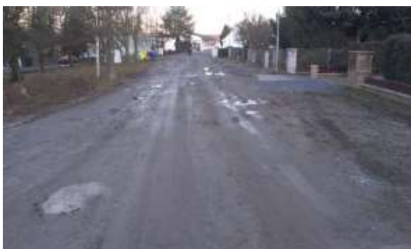
Ulice 9. května před rekonstrukcí
