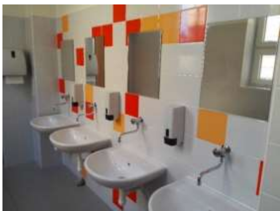
Rekonstrukce sociálního zařízení v budově ZŠ ves
