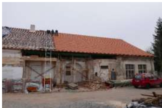
Oprava střechy – č.p.1
