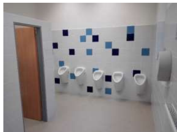
Rekonstrukce sociálního zařízení v budově ZŠ ves
