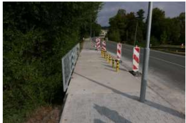
Rekonstrukce lávky při komunikaci ul. Americká
