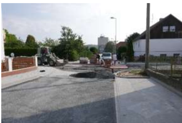
Rekonstrukce ulice Lidická
