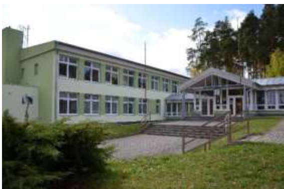
Zateplení budovy ZŠ Chanos
