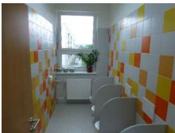
Rekonstrukce sociálního zařízení MŠ sídliště
