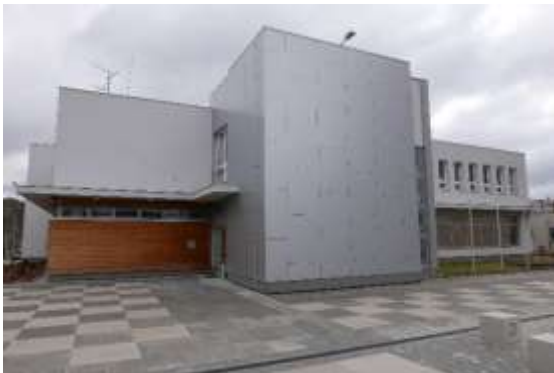
Budova MěÚ po rekonstrukci
