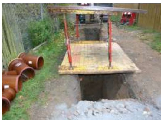
Výstavba nové kanalizace v ul. Zahradní
