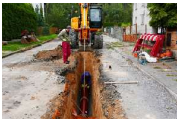
Rekonstrukce kanalizace v ul. Lidická
