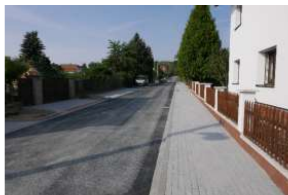
Rekonstrukce ulice Lidická
