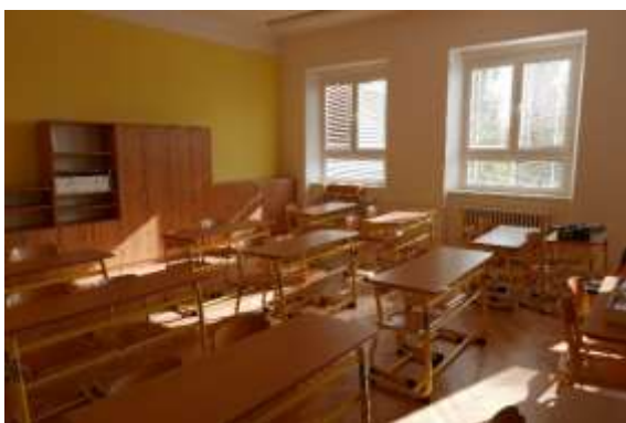
Výměna oken a opravy podlah ve třídách ZŠ ves
