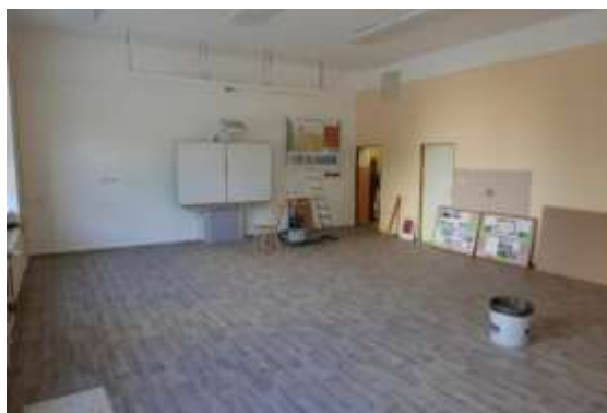
Rekonstrukce učebny chemie ZŠ ves
